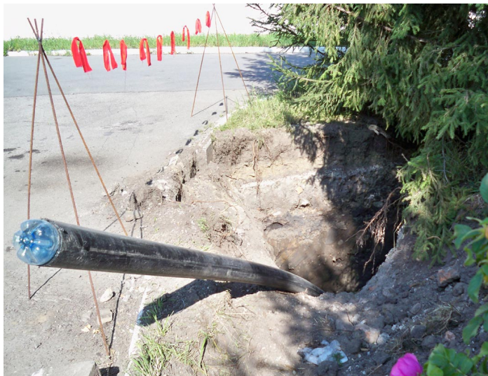
Реконструкция водопровода. 2009 год.
